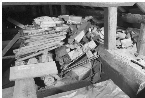
内藤清兵衛家（美好町）屋根裏で発見された大量のお札群は、俵三つの中につめこまれていただけでなく、俵の上部にむきだしのまま積み上げられていた。
