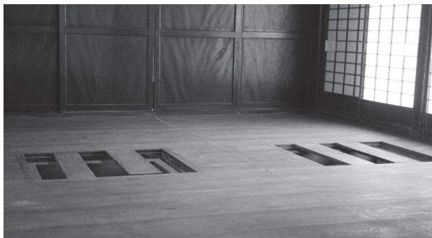
旧河内家住宅の床に設けられた炉
