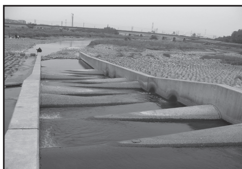
大丸堰のハーフコーン型魚道
