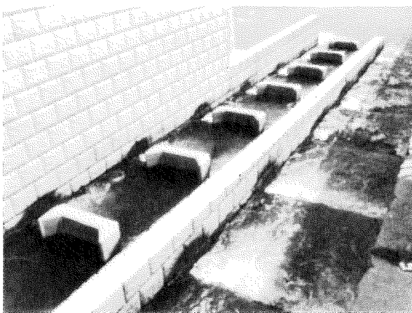
二ヶ領せせらぎ館下(宿河原堰)の魚道
