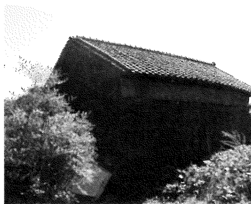
住吉町内藤家のコクラ（穀蔵）。梁には弘化2年（1845）の建立の銘があることを確認した。
