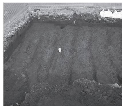
道路 A 路面
