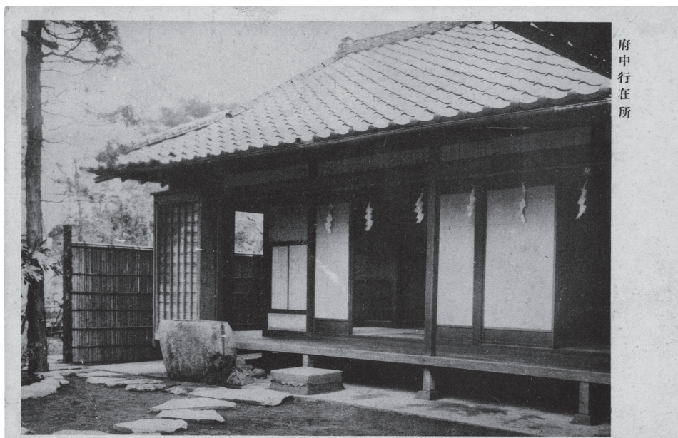
1942年、府中行在所の修繕工事竣工式に記念品として配られた絵葉書
