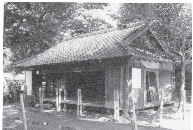
移築に伴う解体直前の旧田中家住宅御座所
