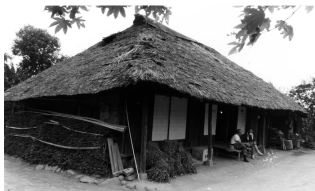
解体前（1968年頃）の旧越智家住宅。屋根は茅葺のままであり、周囲には焚木が積まれている。
