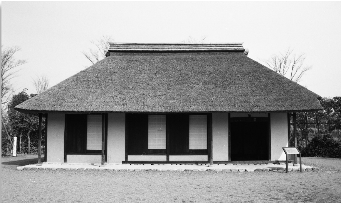
復元工事が完了した頃の旧越智家住宅。防風林（カシグネ）として植えられている樹木がまだ小さく、屋根の茅も葺きたての状態。
