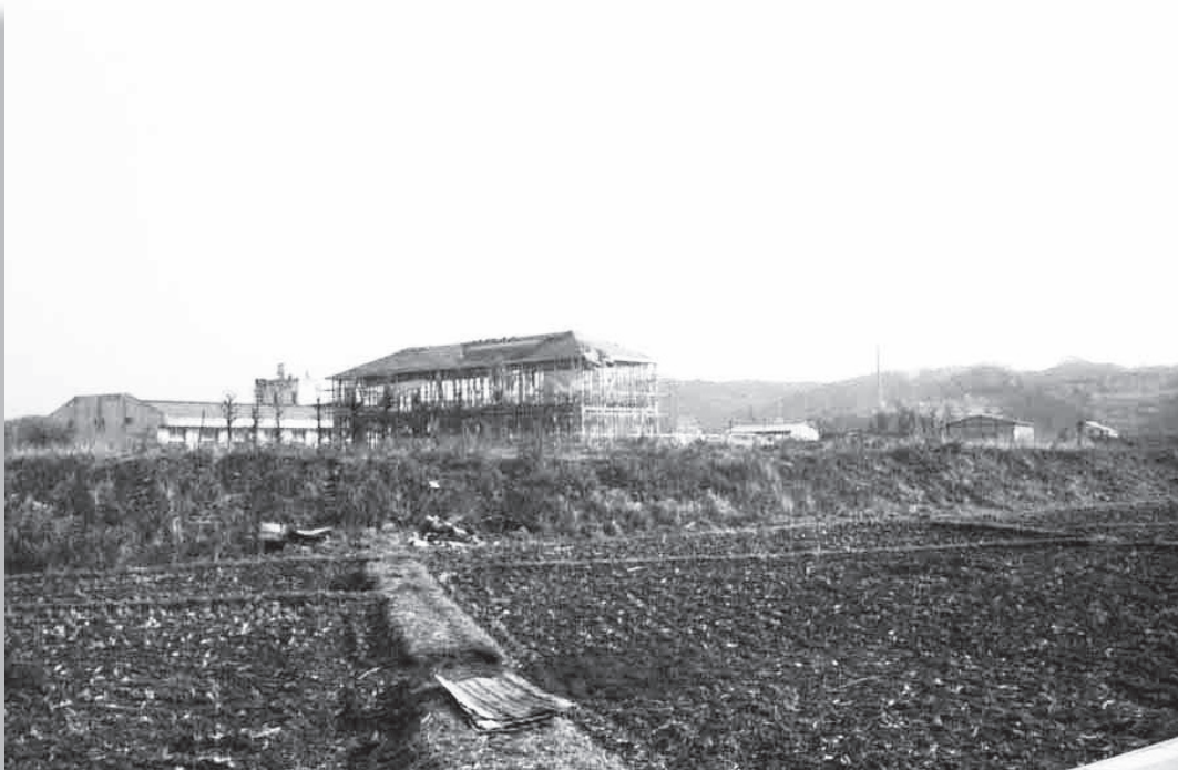
「郷土の森」建設予定地に復元工事中の、旧府中尋常高等小学校校舎。左に見えるのは、現在観光物産館となっている場所にあった都立青年の家。
