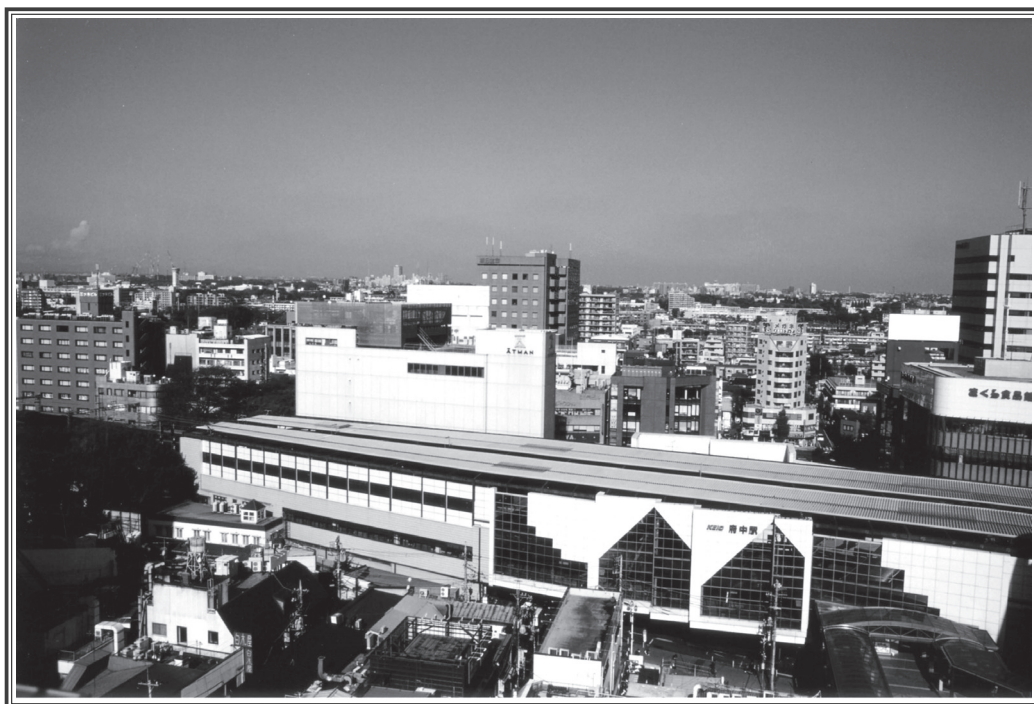
伊勢丹の屋上から見た府中駅の駅舎（2008年撮影）
