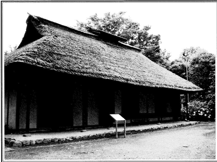
府中市郷土の森博物館内の復元建築物 旧河内家住宅（市指定文化財）
